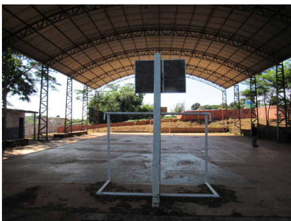
Foto 04 – Vista geral interna da Quadra
