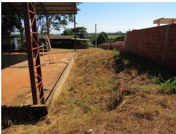
Foto 06 – Vista do local dos futuros Sanitários; à direita, muro de divisa com a sobra de terreno
